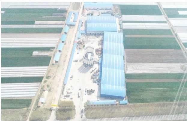
图 6.9-12 3 标山东路桥拌合站（已移交）
