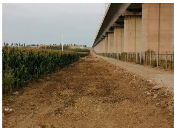
图 6.9-35 施工便道平整、复耕
