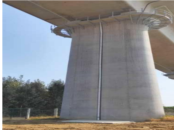
落药河饮用水水源保护区集中排水管和集水池
