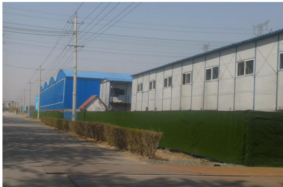
施工场地围挡
