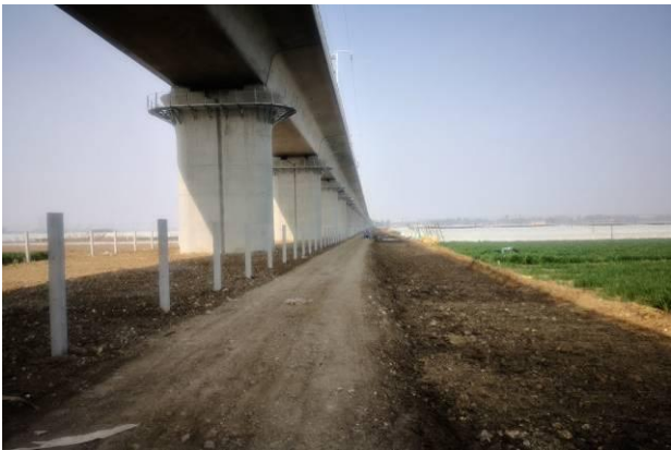
图 6.9-33 已复垦施工便道
