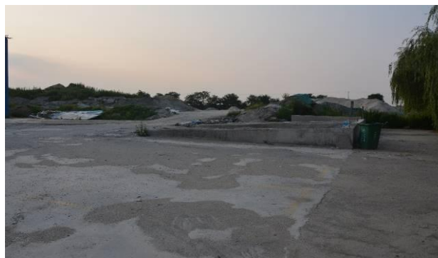
图 6.9-15 4 标 3#拌合站（正在拆除）
