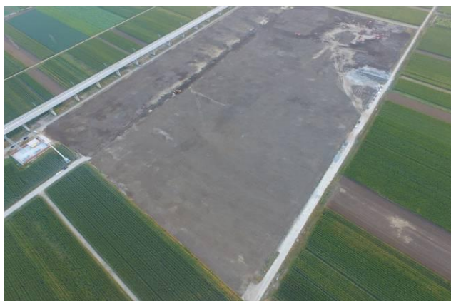
图 6.9-3 平度西制梁场（正在复垦）
