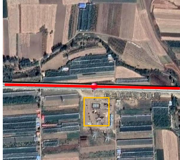
杨兰埠牵引变电所
