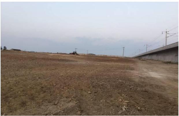
图 6.9-13 3 标 1#拌合站（已复垦、正在移交）
