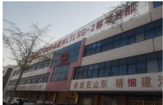
图 6.9-21 2 标项目部驻地（正在使用）
