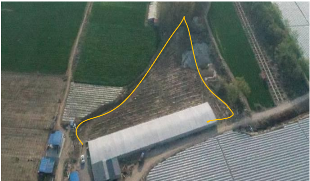
图 6.4-4 北孟镇朱家屯弃土场航拍片
