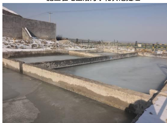
5 标制梁场三级沉淀池
