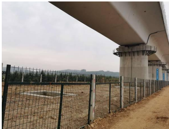
小沽河饮用水水源保护区集中排水管和集水池
