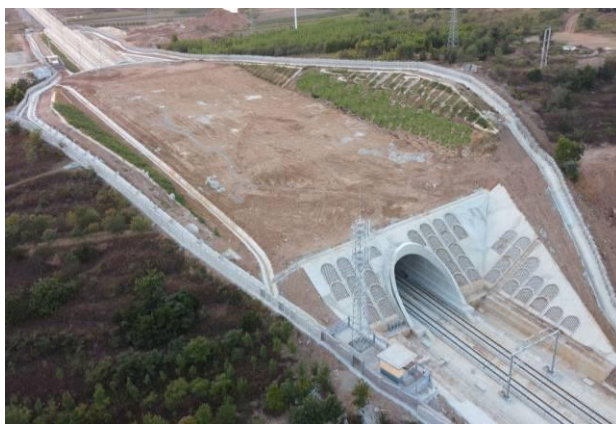
图 6.7-2 隧道洞顶平整
