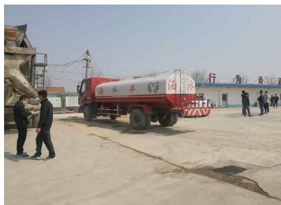
施工便道洒水降尘
