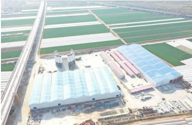
图 6.9-10 2 标 1#拌合站（国土部门出具转移手续）
