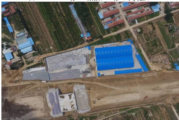
图 6.9-30 4 标 2#小型构件预制厂（未复垦）
