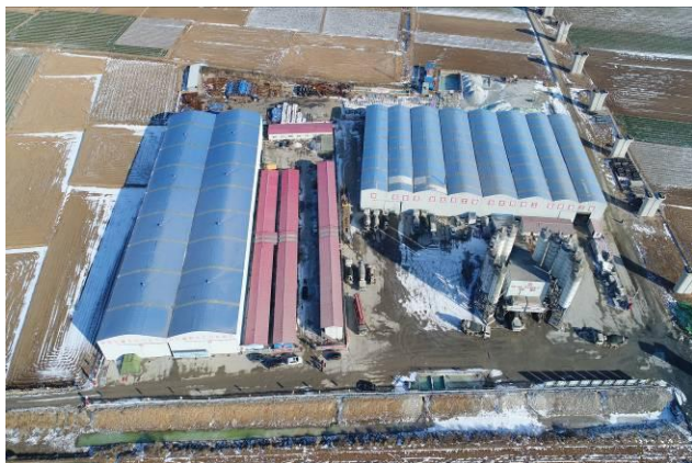
图 6.9-28 2 标 1#钢筋加工场（未复垦）
