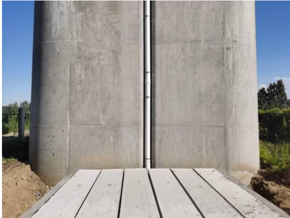
白沙河饮用水水源保护区集中排水管和集水池
