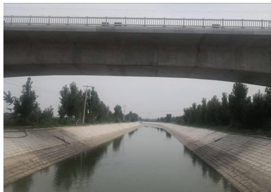
图 6.6-6 引黄济青干渠跨河大桥
