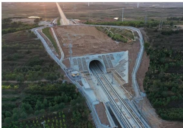
图 6.7-1 隧道洞口防护
