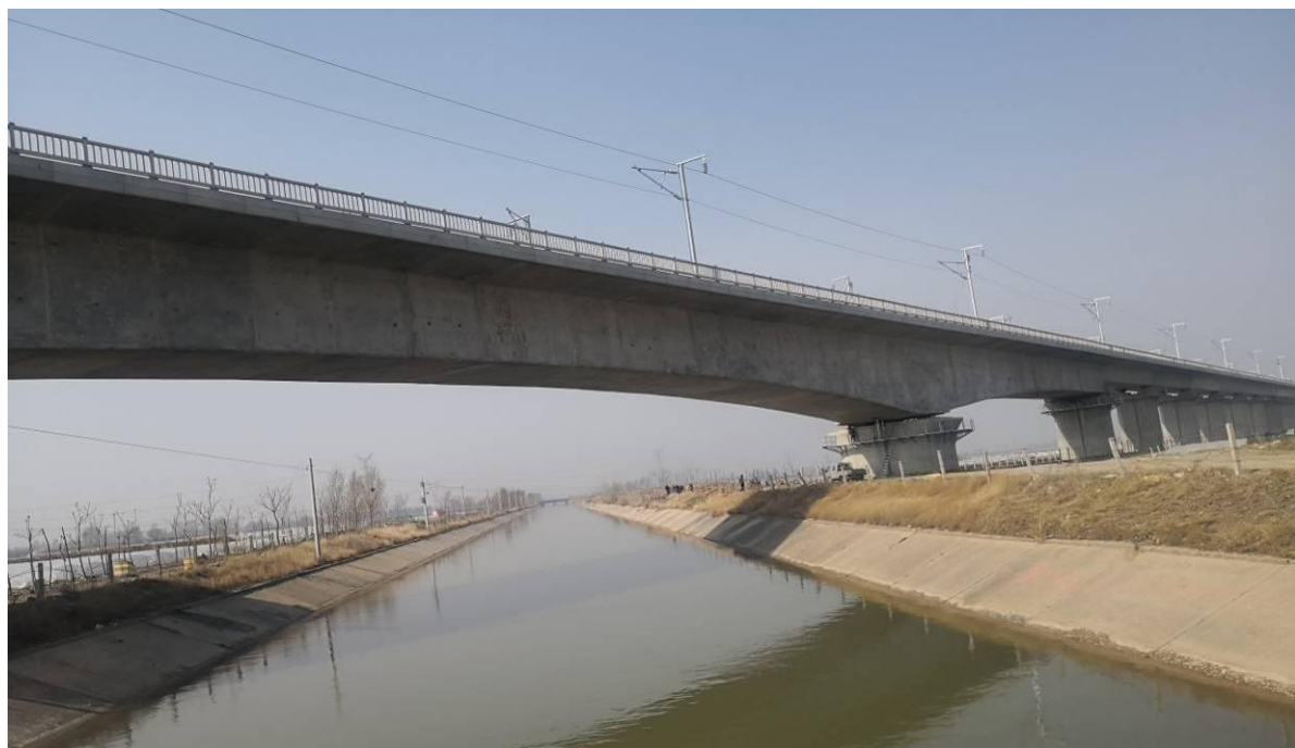
9.2-8 工程与引黄济烟饮用水干渠相对位置关系、现状照片
